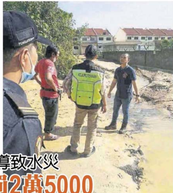
■工程的疏忽而导致毗邻住宅区发生水灾。（照片余深恩提供）
